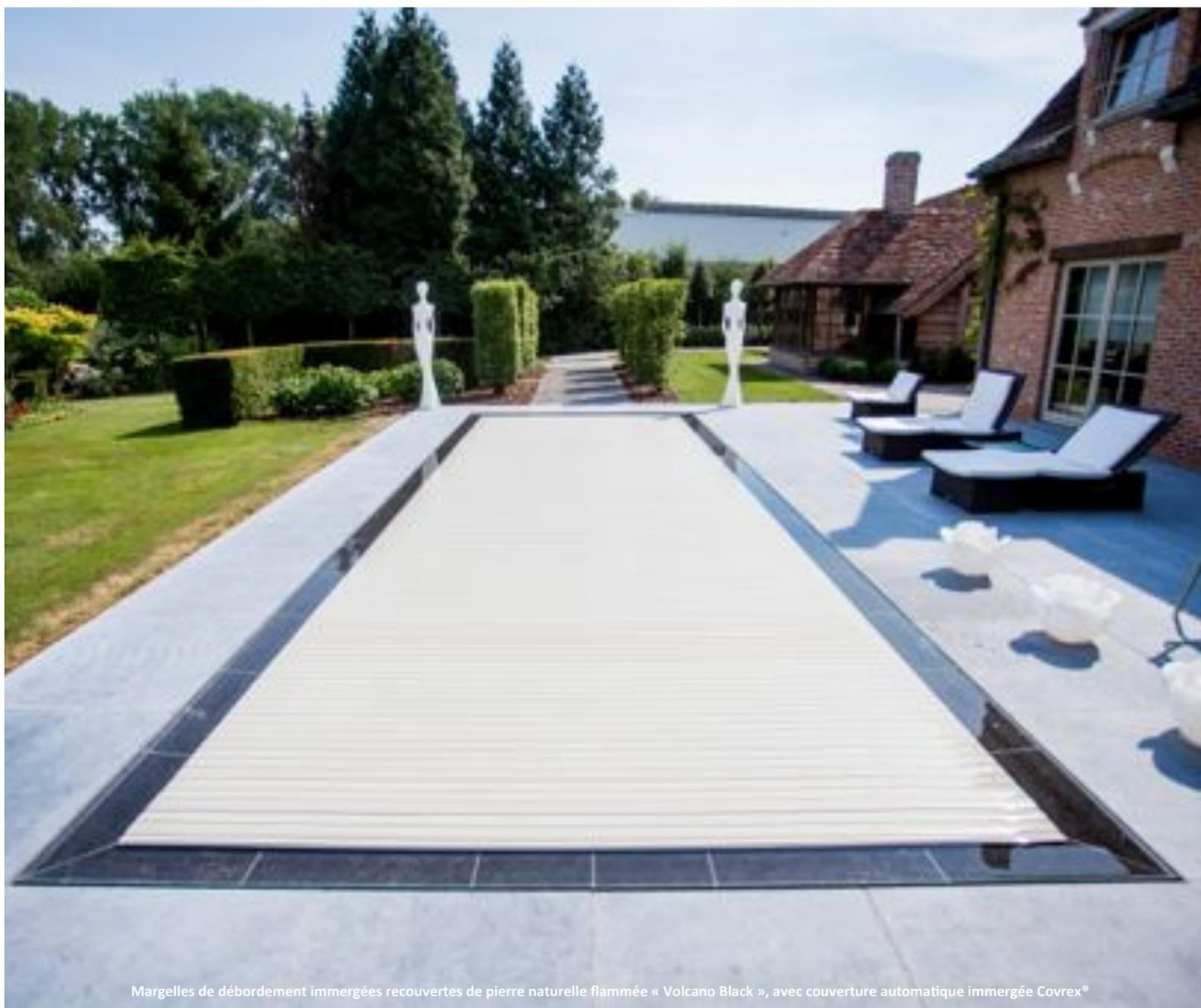
Margelles de débordement immergées recouvertes de pierre naturelle flammée « Volcano Black », avec couverture automatique immergée Covrex®
